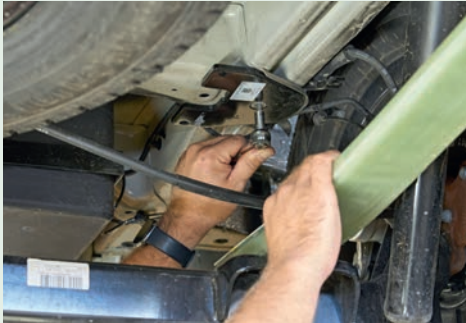
4 Die Aufnahme für den Balg der Luftfeder kommt an die Stelle des Anschlagpuffers.
