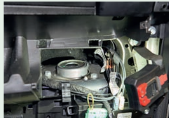
2 Dahinter verstecken sich die Federdome, an denen die Domlager befestigt sind.
